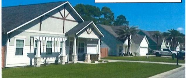
WATER'S EDGE SUB
